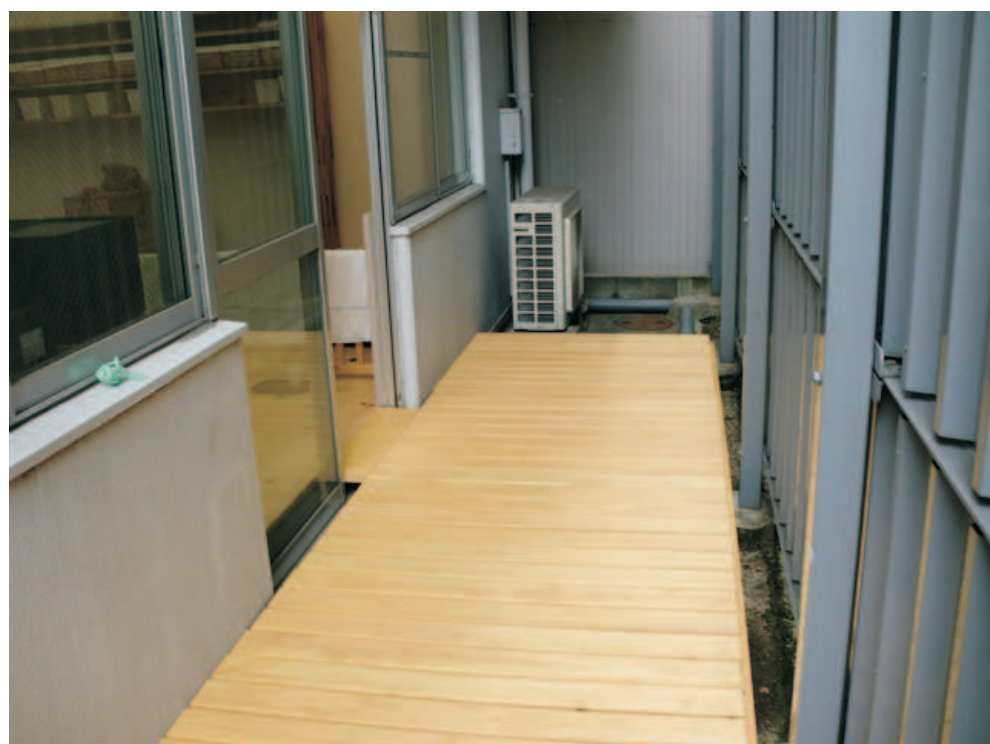
ウッドデッキ完成 室内より安全に出入り 出来るようバリアフリー になっています
