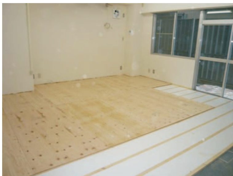
床工事 断熱材
