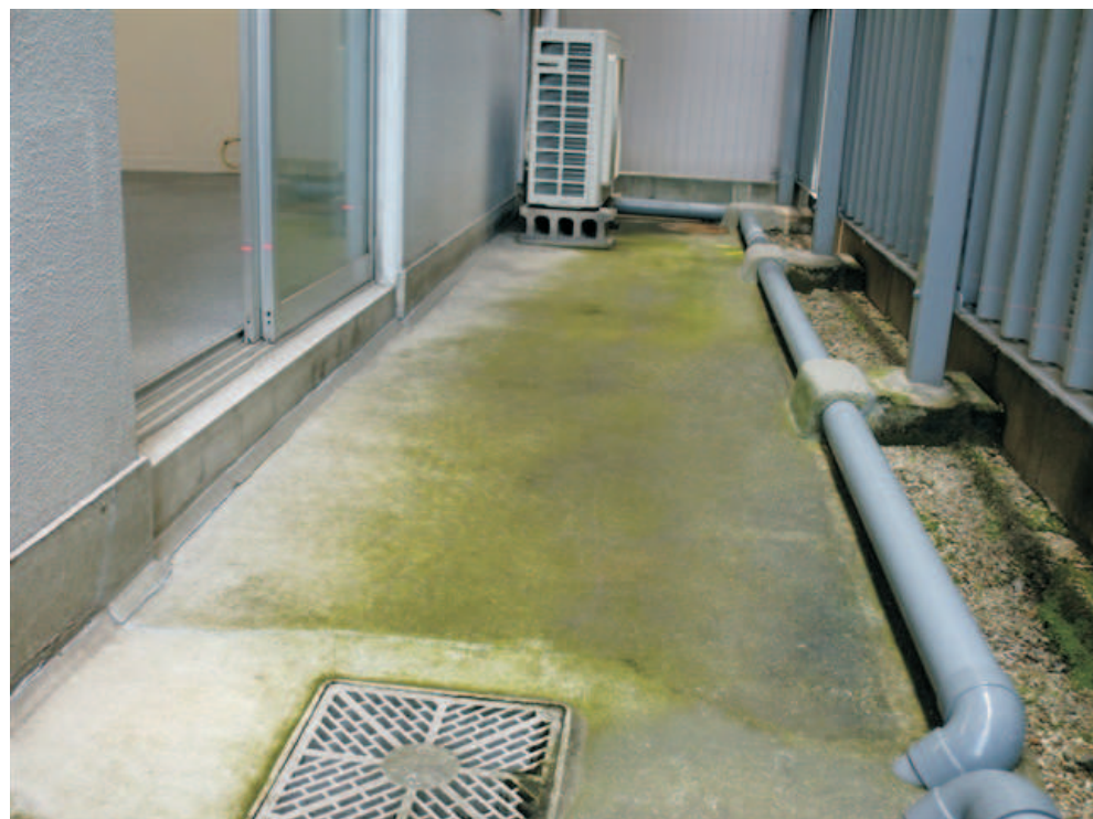
外部 ウッドデッキ工事 着工前
