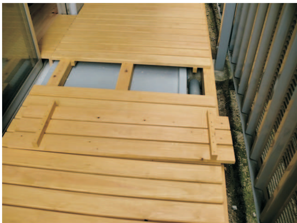
夏プール遊びが出来るよう ウッドデッキ床下に防水槽を 整備しました また、水槽掃除ができるよう 床を取り外しできるよう になっています。
