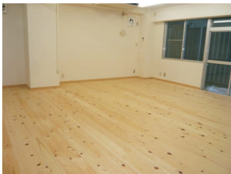
桧フローリング リ完成
